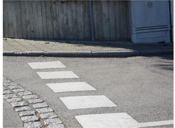
Bei der Einmündung des St. Leonhard-Weges sind die Gehwegkanten nicht abgesenkt.
