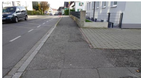
An der Einmündung des Zimmererwegs in die Radolfzeller Straße ist eine Rinne zwischen Belag und der Bordsteinkante. Das kann zu einer Stolperstelle führen.
