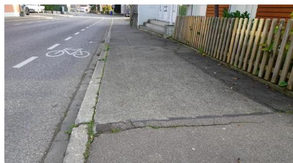
In der Radolfzeller Straße bei Hausnummer 67 drücken die Wurzeln einer Ranke die Gehwegoberfläche hoch. Dadurch kann eine Stolperstelle entstehen.
