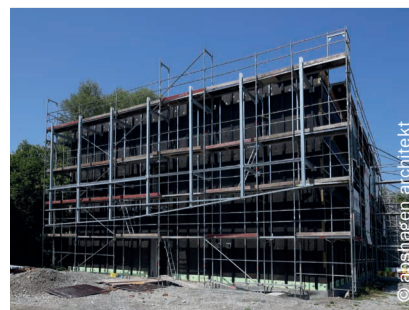
Bau des neuen Zentraldepots
