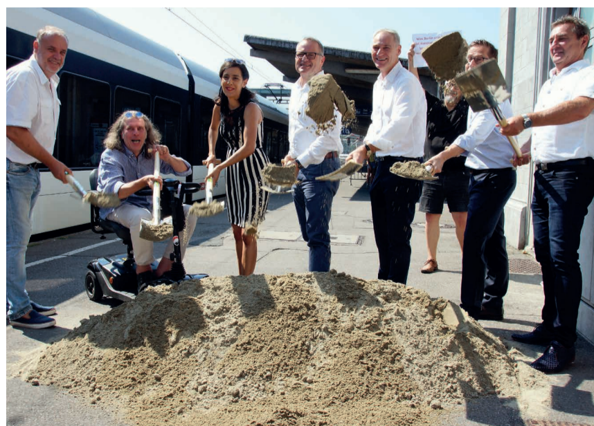
Der Spatenstich für die Errichtung der zwei Aufzüge an der Unterführung am Konstanzer Bahnhof fand am 3. August statt. Mit dabei (v.l.n.r.): Siegfried Zürcher (ZürcherBau GmbH), Stephan Grumbt (städtischer Behindertenbeauftragter), Nese Erikli (Landtagsabgeordnete), Michael Groh (Leiter des DB Station&Service AG Regionalbereich Südwest), Bürgermeister Karl Langensteiner-Schönborn, Jörg Selert (Projektleiter, DB Station&Service AG Regionalbereich Südwest) und Dieter Gaßner (Leiter Bahnhofsmanagement, DB Station&Service AG Regionalbereich Südwest).
