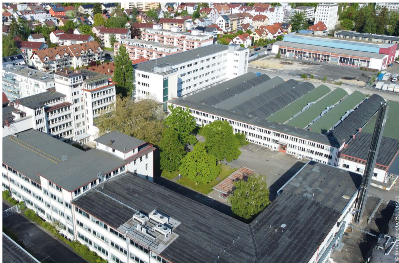
Das Konstanzer Innovationsareal bietet Raum für Gründung und Innovation. Zwischen farm und innolab bodensee liegt die denkmalgeschützte Shedhalle mit ihren markanten Lamellendächern und viel Raum für Kreation und frische Ideen.
