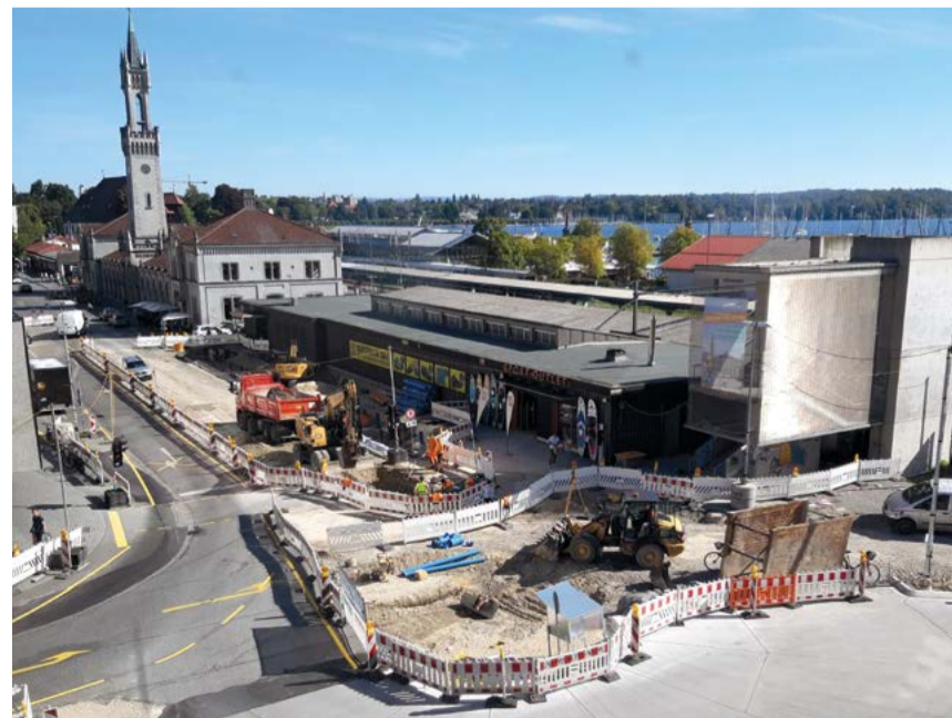
Seit Mitte Mai laufen die Sanierungsarbeiten am Konstanzer Bahnhofplatz. Ein Teil des neuen Kreisverkehrs (am Bildrand unten) ist bereits betoniert, aktuell arbeiten die beauftragten Firmen schon am zweiten Bauabschnitt.
