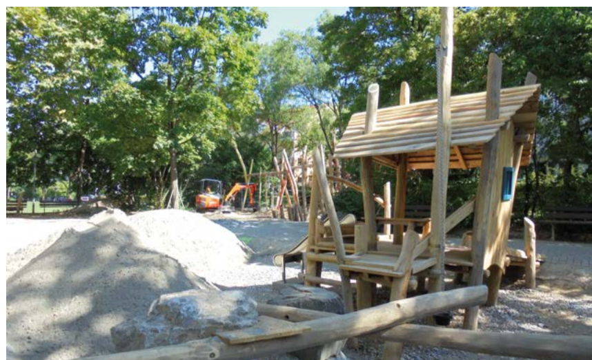
Die Arbeiten am Spielplatz Georg-Elser-Platz sind mittlerweile abgeschlossen. Das Bild zeigt den Stand Mitte August.
