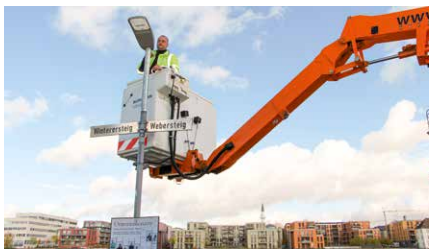
Christian Trapp von den Energienetzen der Stadtwerke Konstanz ist damit beschäftigt, die LED-Leuchten im Rahmen des Pilotprojekts am Weber- und Winterersteig entlang des Seerheins funktionstüchtig zu machen.
